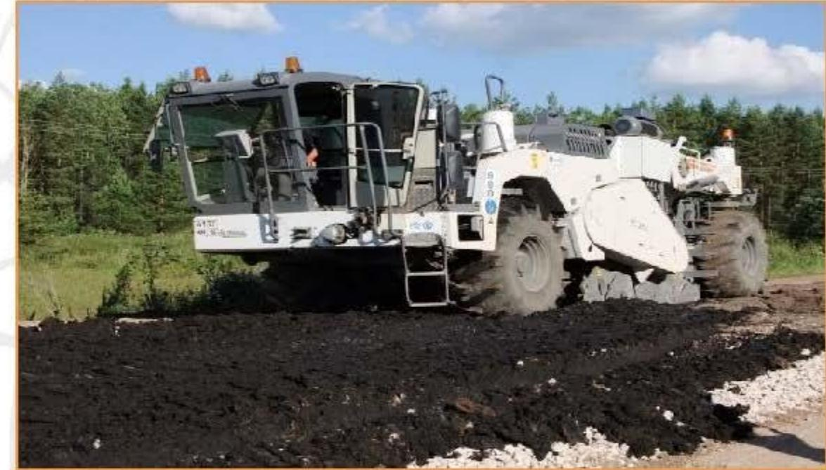
В 2017 году на автомобильной дороге «Актюбинск – Алферовка» выполнен участок с применением смеси на основе местного щебня и твердого нефтяного шлама в основании;
